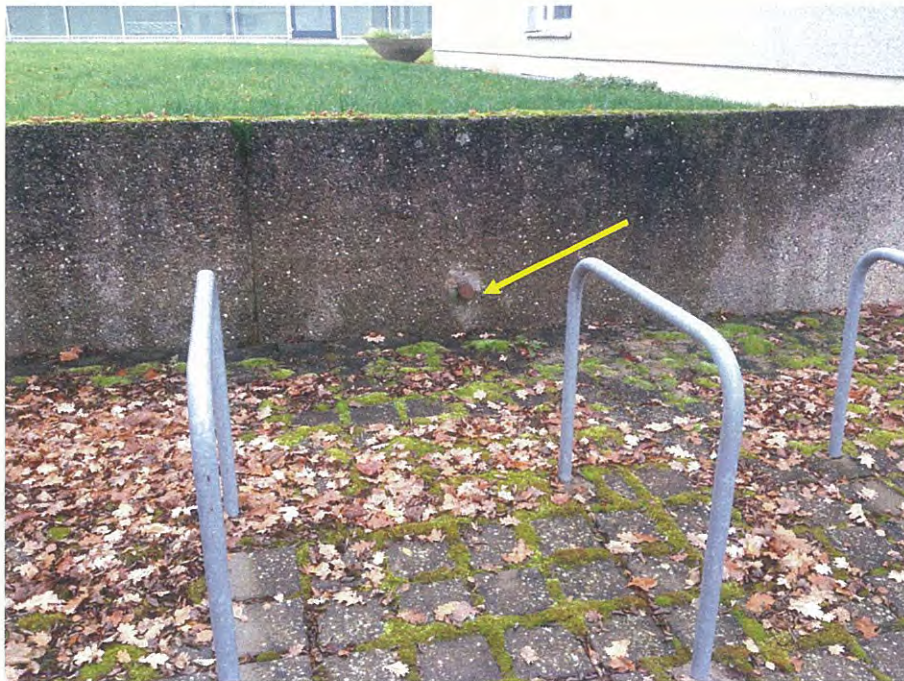
Foto 3: Ölbefüllstutzen an den Heizöltanks. 27.11.2012.
