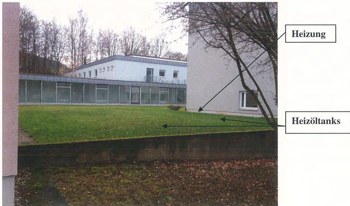
Foto 2: Blick in Richtung Südosten, rechts: Verwaltung. 27.11.2012.
